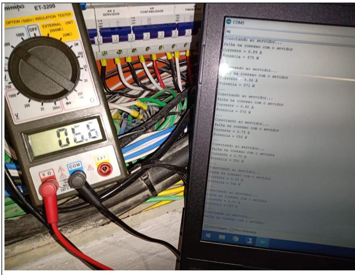
Figura 11: caixa de disjuntor junto com multímetro e protótipo.
