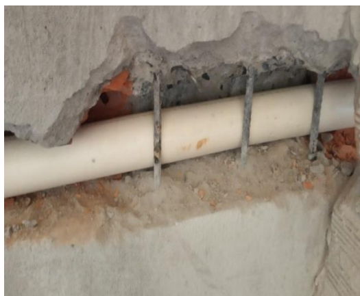
Figura 4 – Encanamento dentro do pilar (obra 04)
