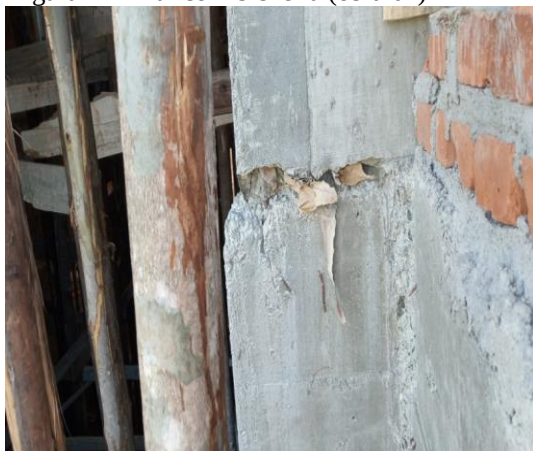
Figura 2 – Pilar com bicheira (obra 01)
