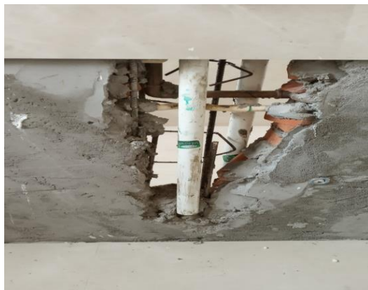
Figura 3 – Encanamento dentro do pilar (obra 04)
